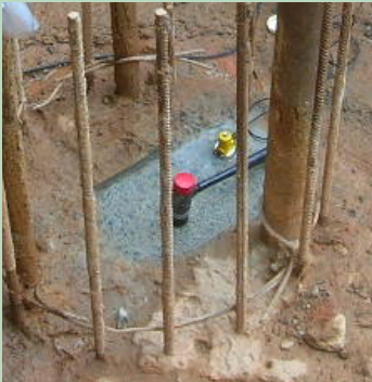
Figure n°1 : Mise en œuvre des essais en tête de pieu
